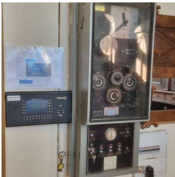
Cette année, le système de commande des cloches de l'église de Manhac a fait peau neuve. Le vieux tableau de commande a été remplacé par une horloge électronique moderne.
